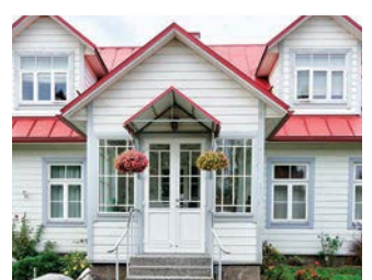
UNTERSICHTEN UND FASSADEN
