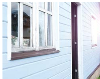
AUSBESSERUNGEN IM AUSSENBEREICH
